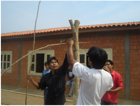
Figura 28 – Definição da curvatura do zav káli
