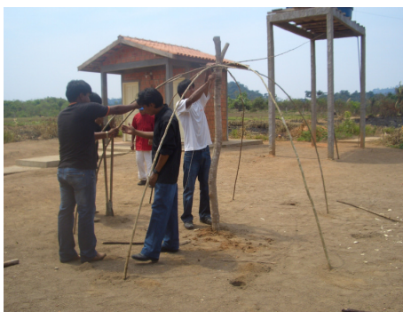
Figura 42. Fixação do sétimo zav káli
