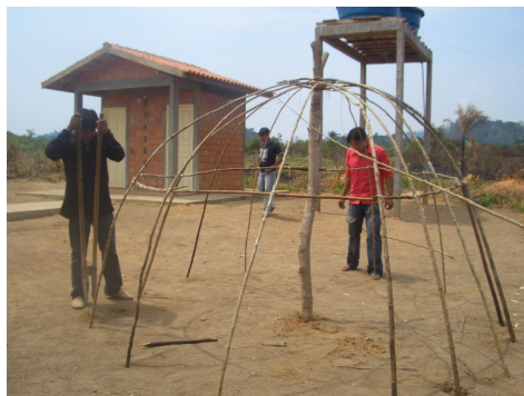
Figura 46. Continuação do processo - fixação dos zav káli
