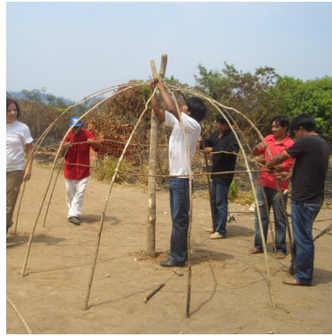
Figura 44. Fixação do décimo segundo zav káli
