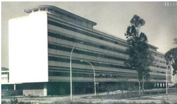
O antigo prédio - http://www2.fe.usp.br/estrutura/cme/curiosidades.html
